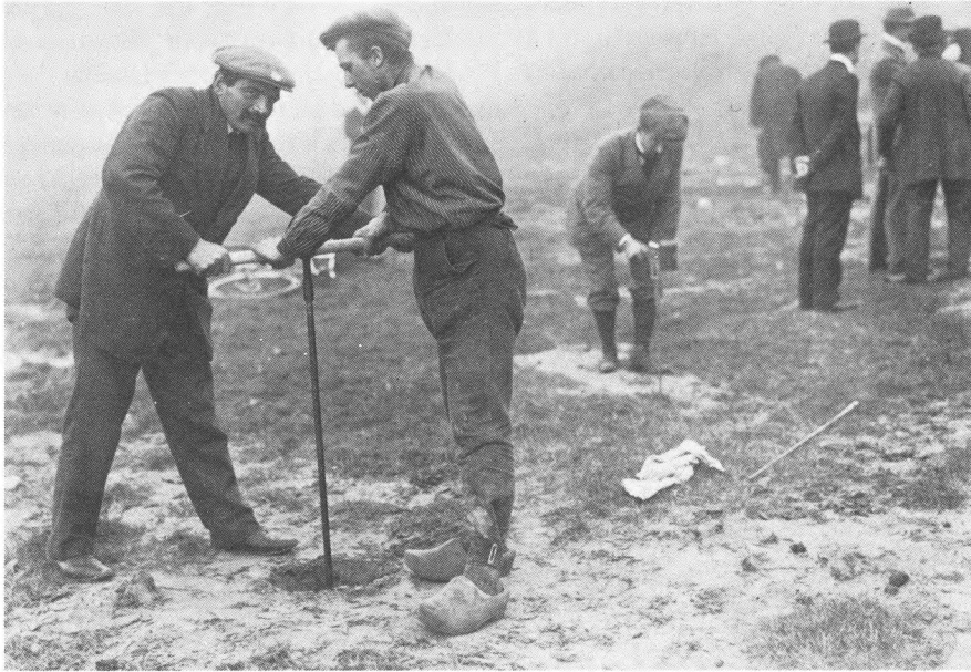
fig. 3 Boring met een 2 meter lange boor om verschillende monsters grond te verkrijgen, deze heeft een zeer gecompliceerde samenstelling graniet, vuursteen, zandsteen, leem en stollingsgesteente.
