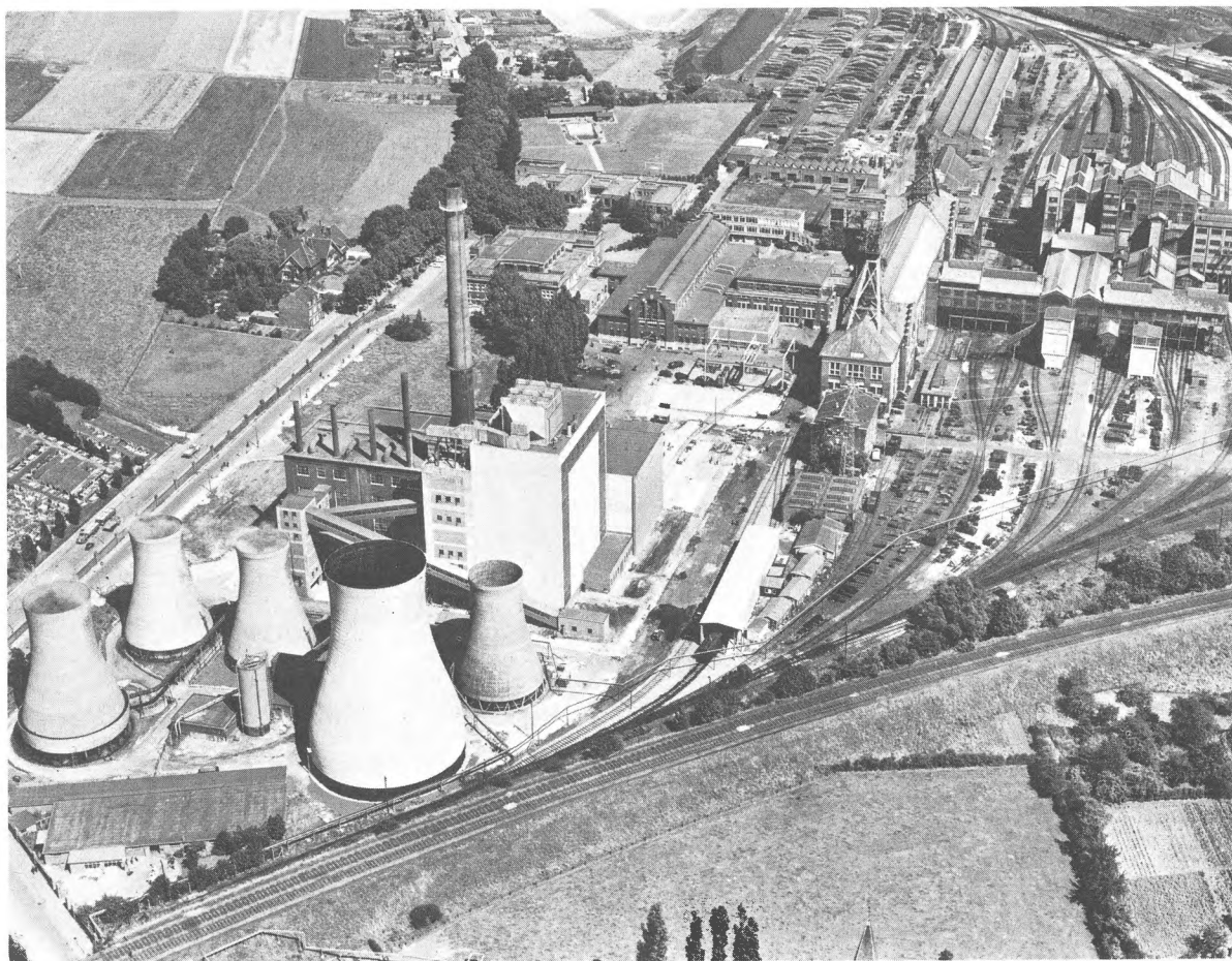
Overzicht van de mijnzetel 'Julia' van de N.V. Laura en Vereeniging te Eygelshoven. Begin van de kolenproductie in 1926. View of surface facilities Mine Julia (Laura Mining Company), Eygelshoven. Start of coal production 1926.
