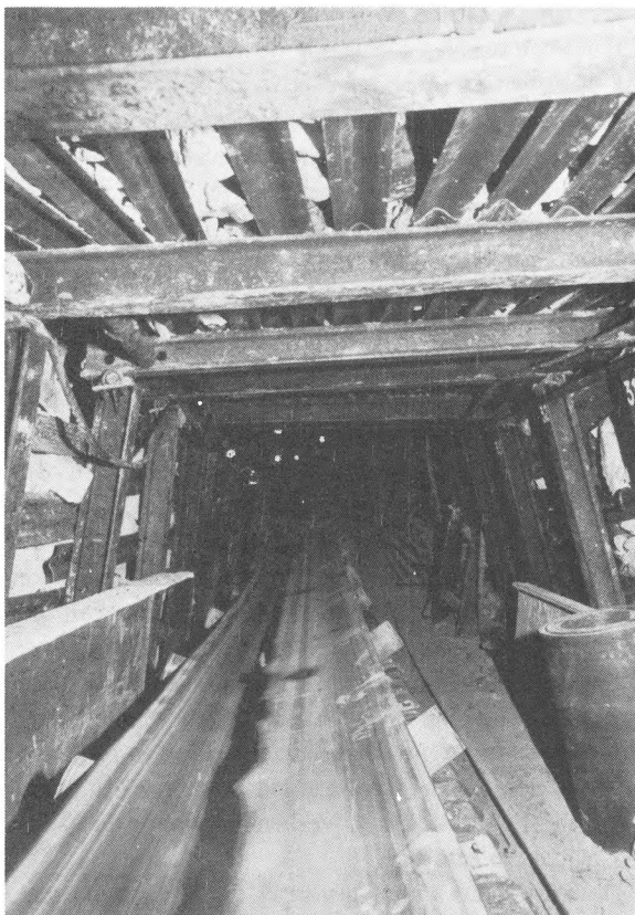
Foto 5 Opgravingsgalerij met stalen ondersteuning en transportband-installatie.
